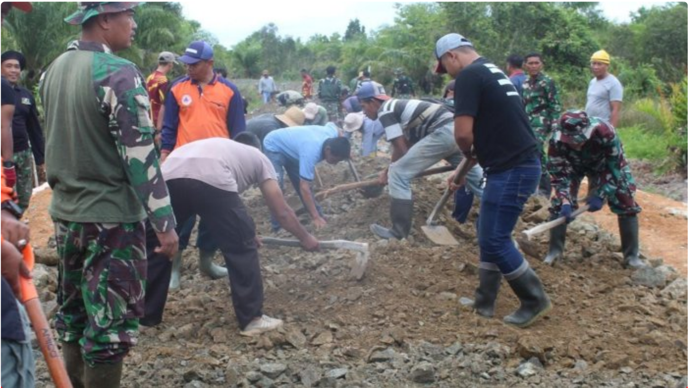
TMMD Ke 117 Desa Telaga Langsung, Bangkitkan Jiwa Gotong Royong Warga
