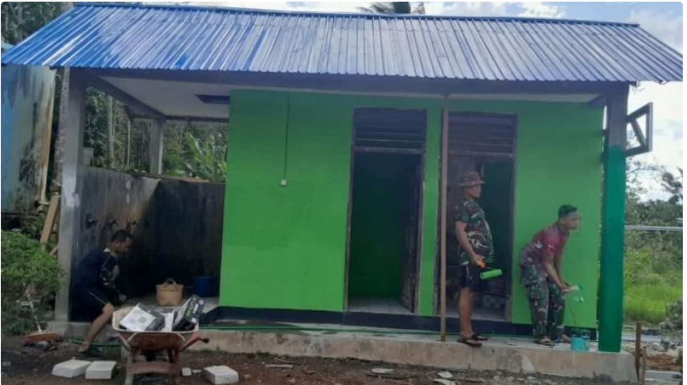
Pengerjaan Sasaran Rehab Masjid, Tinggal Finising
