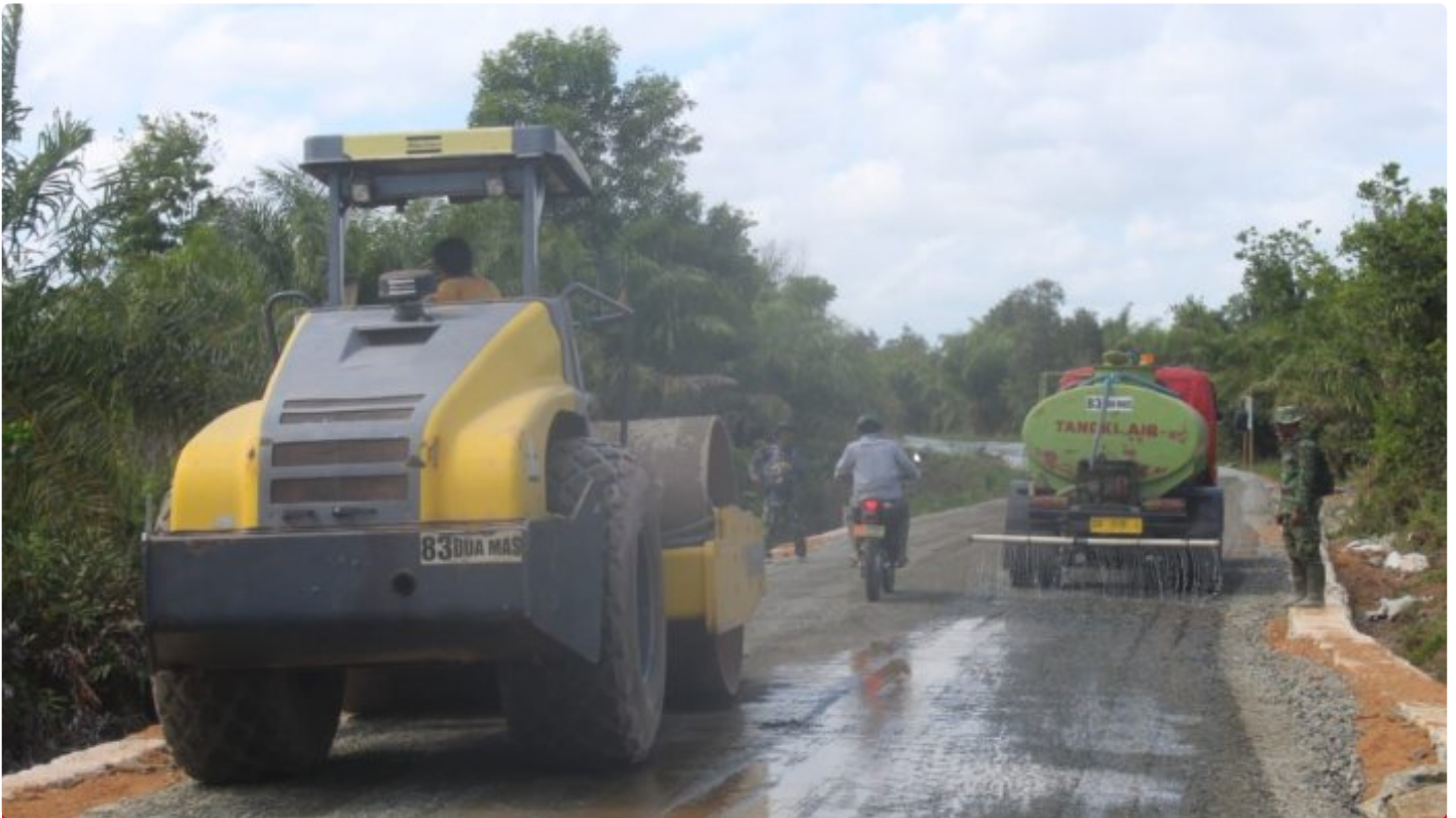
Memasuki Hari-Hari Terakhir, Pengerjaan Sasaran Jalan Di Kebut
