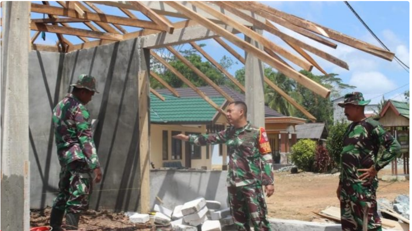
Dansatgas TMMD, Tinjau Langsung Perkembangan Dilapangan
